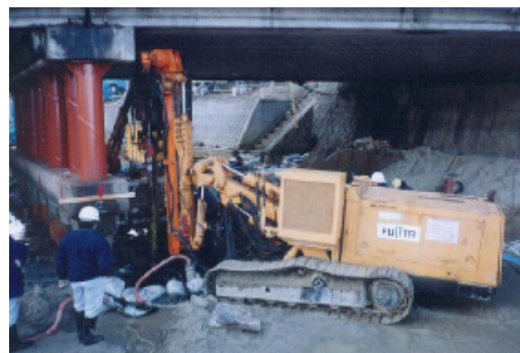
写真 - 1 HMP 施工状況
