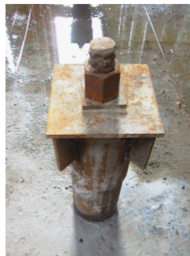
写真 - 2 杭頭処理状況
