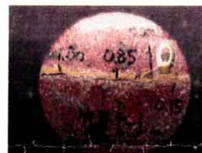
写真4. 中性化深さ (C J 断面方向)
