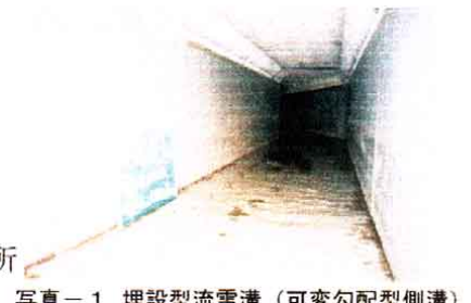
写真-1 埋設型流雪溝(可変勾配型側溝)
