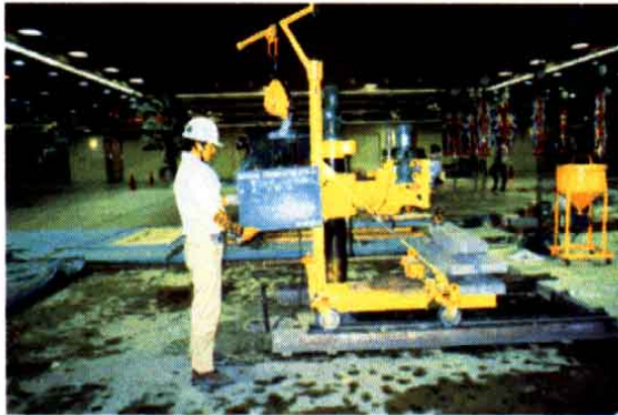
図3 ウォータージェット機械設置状況
