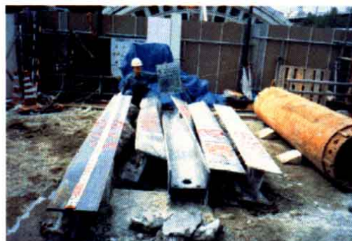
図2 撤去完了した芯材
