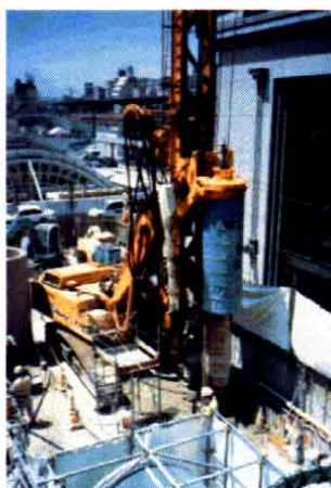
図1 BG機による撤去状況
