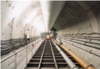
写真 - 1 坑内状況
