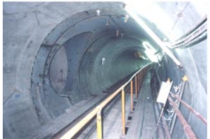
写真－1 鋼管ライニング状況
