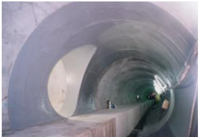
写真－2 仕上がり状況
