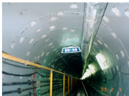
図 - 3 国道一号線直下部
