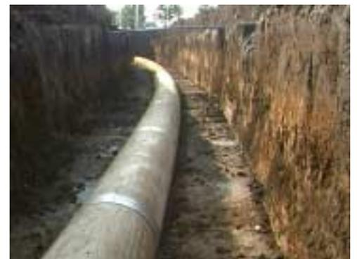
写真-4 開削による精度の確認
