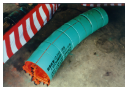
写真-1 掘進機全景
