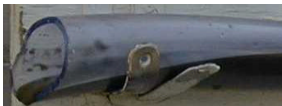
写真-1 充填されない場合のグラウト例
