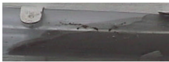
写真-4 グラウト先端部の状況(スラグ使用)
