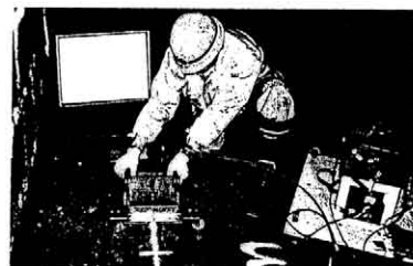
写真－１ レーダ計測状況
