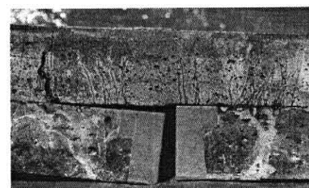
(b) 既設コンクリート：滑面
