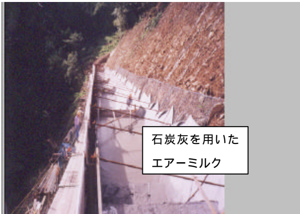
写真 - 1 軽量盛土工での石炭灰を用いたエア－ミルクの投入状況
