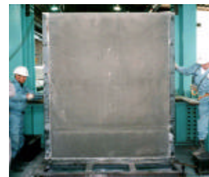
写真 - 1 泡モルタルの充填状況（脱型時）
