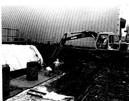
Fig.6 コンクリートの施行状況
