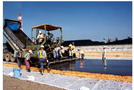
写真 - 2 貯炭場固化盤の施工状況
