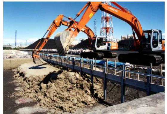
写真 - 1 道床固化盤の施工状況
