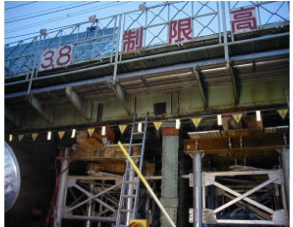
写真—2 鋼バンド工
