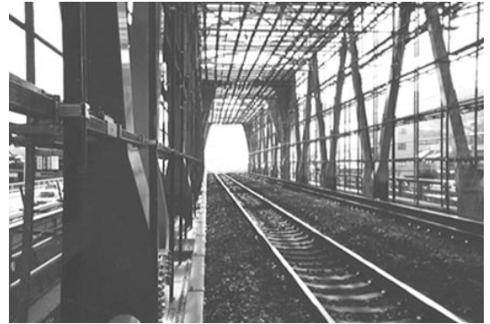
写真-1 足場設置状況
