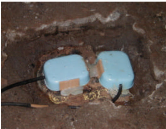
写真1 ゲージ取付状況
