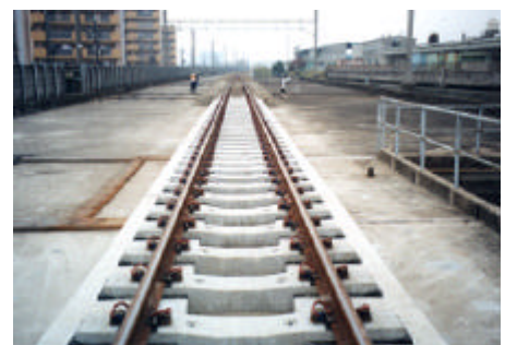
写真1 省力化軌道の試験敷設
