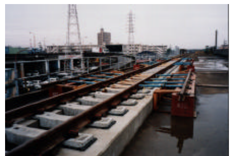
写真2 レールの仮設支保工
