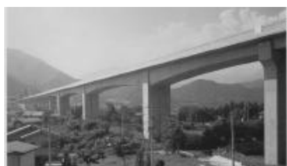
写真－1 山梨実験線都留明かり区間
