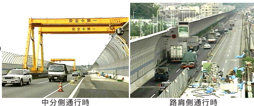
図-2 工事規制中の状況
