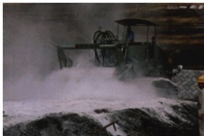
写真— 1 混合攪拌の状況
