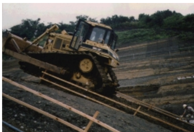
図—2 法面での転圧施工の状況
