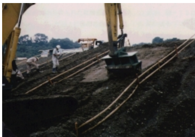
図—3 ローターによる仕上げ転圧の状況
