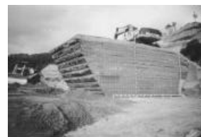
逆勾配形状の盛土
