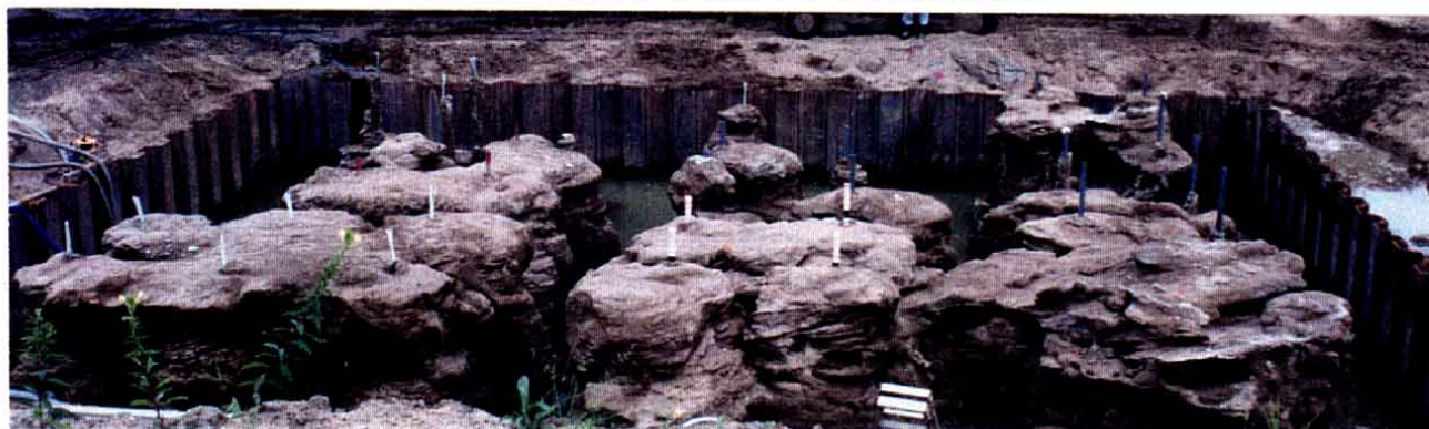
写真－1 野外注入試験における掘削調査状況
