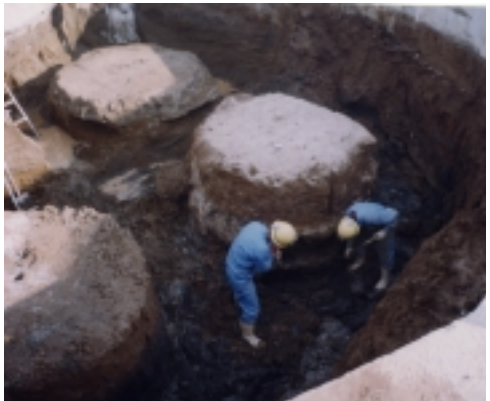
写真-1 掘り出された改良体
