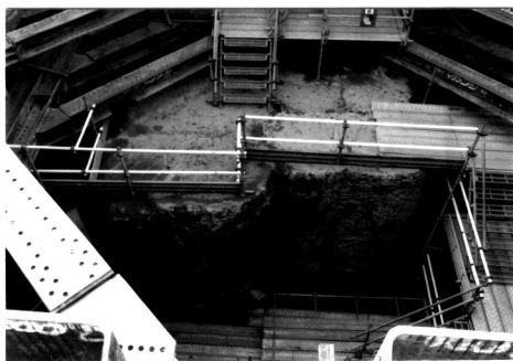
写真－1 仕上り状況
