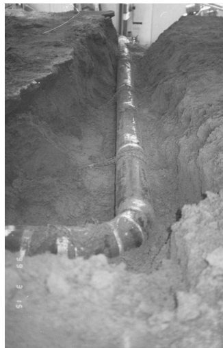
図 - 3 実験後の供試体
