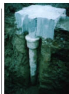
写真-1: 明かり箇所での事前施工状況
