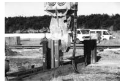
写真-1 試験打設状況
