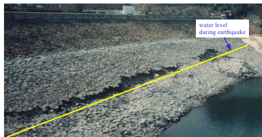
写真-1 アースダム堤体のすべり被災状況
