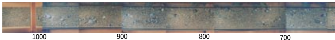
写真-1 BH-12, 通水 5 分後の河床 (通水口から 700cm ~ 1000cm 付近)
