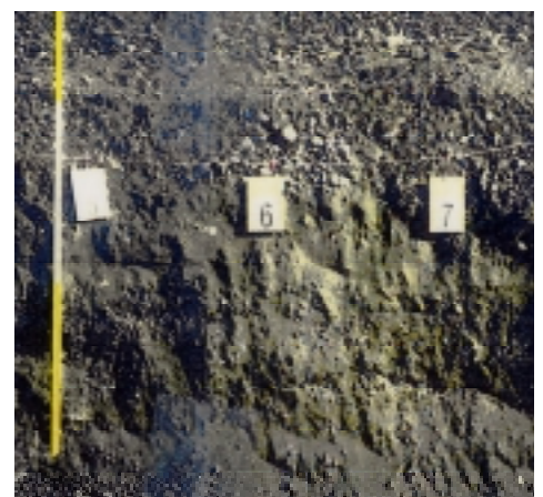
図 - 3 トレンチ調査による浜部砂礫分布状況（大井川右岸測線 No.65）
