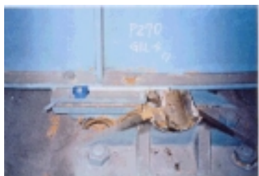
(b) P270 上におけるピン支承の損傷状況
