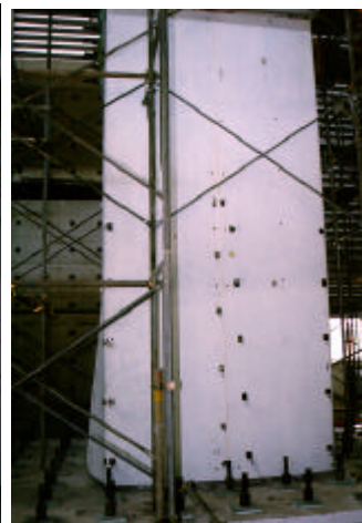
写真-3 鋼板巻き補強
