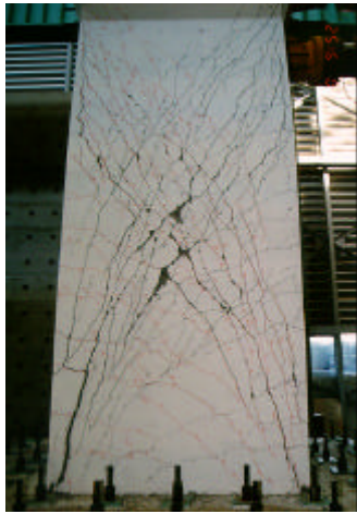
写真-1 せん断ひび割れ
