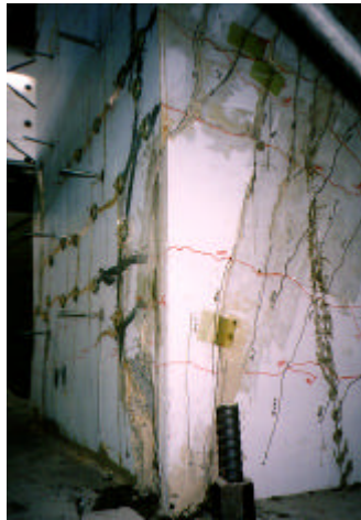
写真-2 補修状況
