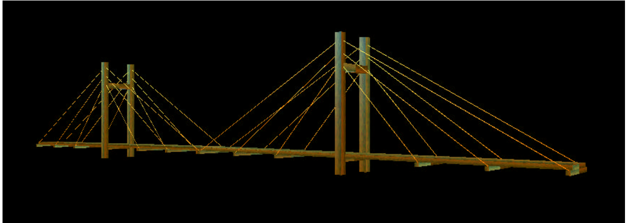
図-3 木製斜張橋の照明事例（赤色の橋に色温度 2000K の照明をあてた場合）
