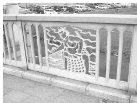
写真—1 東京の蔵前橋
