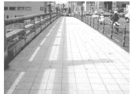
写真 - 4 五条大橋の歩道舗装
