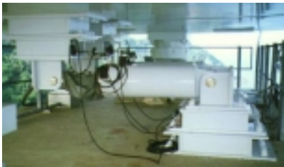
写真 1 油圧ダンパー取付状況 ( P 1 )
