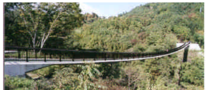
写真 - 1 農村公園グリーンパーク橋(長野県生坂村)
