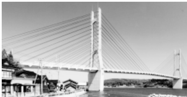
写真-1 中能登農道橋(中島町より)
