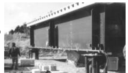
図8：野外試験体への設置状況
