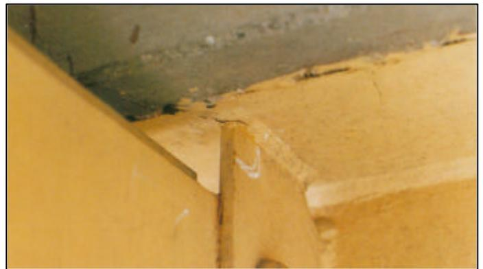
上フランジと補剛材接合部の損傷例
