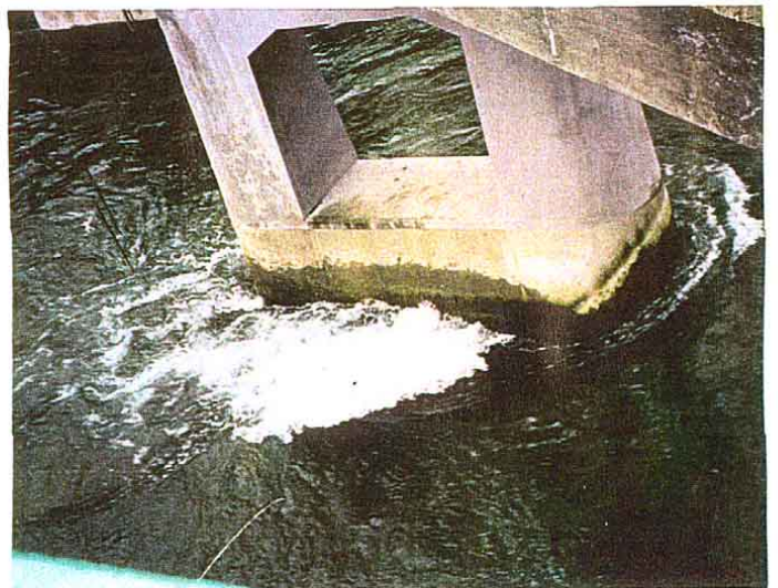
写真-2 振動測定した橋脚付近の水流
