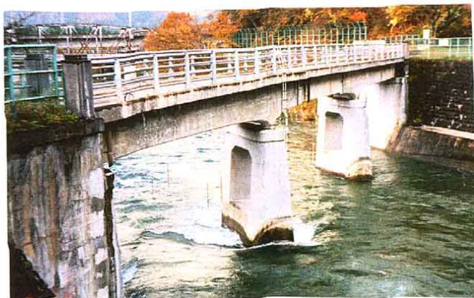
写真-1 微動測定を行った橋梁橋脚
