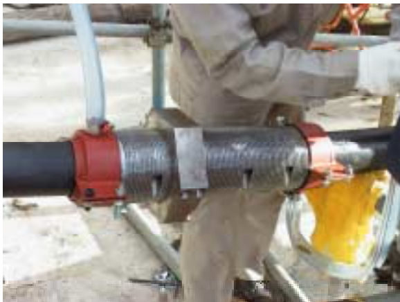
写真-1 施工試験状況
