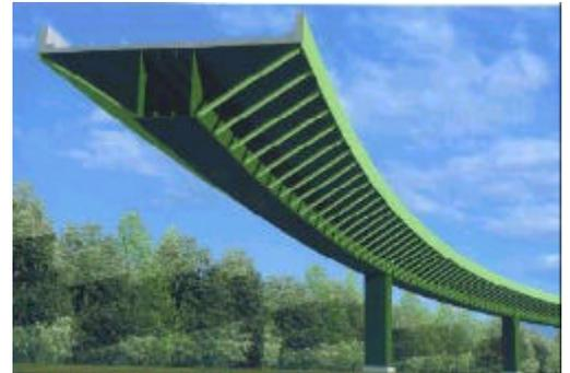
図-1 ストラット付き鋼箱桁橋
