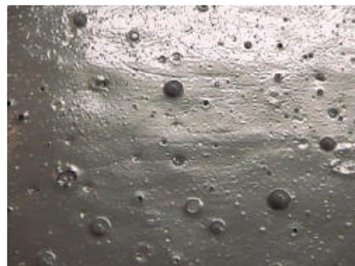
図4. 塗膜系防水工表面の気泡
