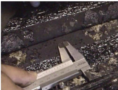
図3. シート材料下の気泡発生
