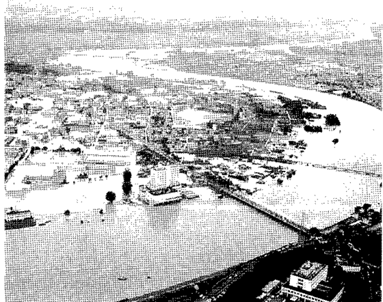
写真－1 水府橋付近被災状況
