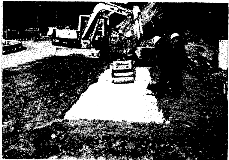
写真-1 発泡廃ガラス材の締固め状況
