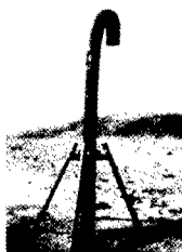
写真-2 ガス抜き管状況
