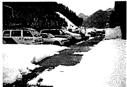
写真-2 掘削杭熱交換システムによる歩道の融雪状況（平成11年1月12日）
